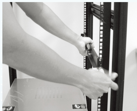
サイドマウントレールをラックに固定します。
