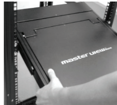
2) LCD KVM 스위치 / LCD 콘솔을 레일 위에 놓고 선반에 고정하세요.
